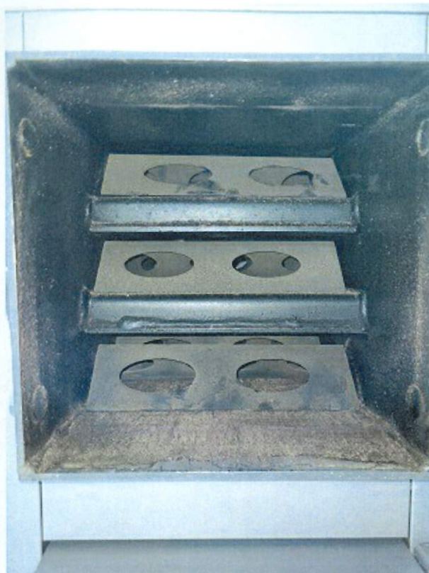
Rysunek 7 Wymiennik oraz zawirowywacze
