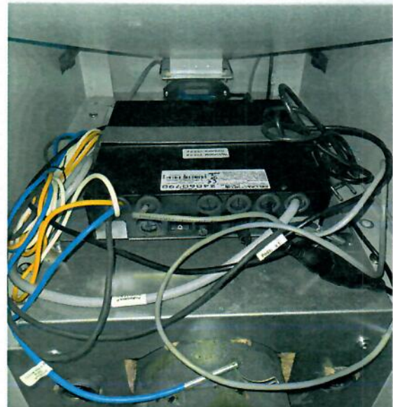
Rysunek 9 Moduł sterownika PELLPAL PLUS firmy ProND
