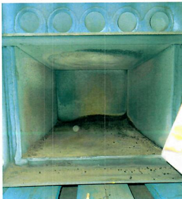
Rysunek 8 Komora spalania i popielnika
