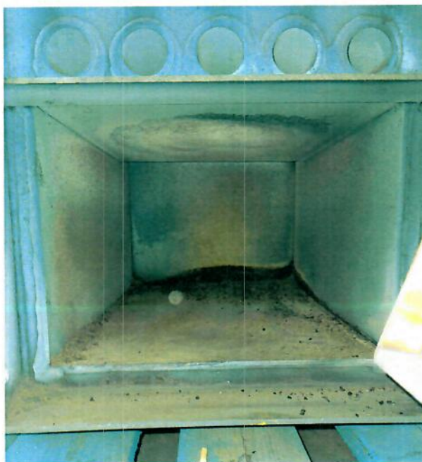
Rysunek 8 Komora spalania i popielnika
