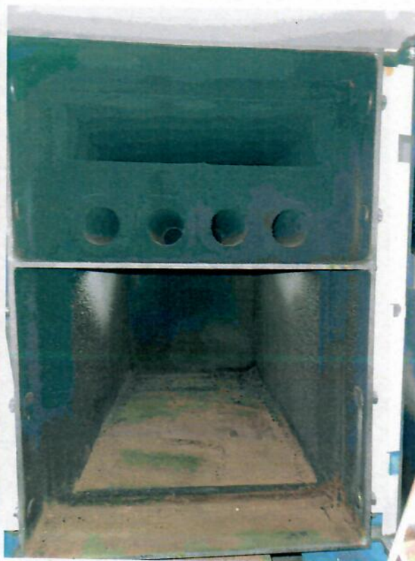
Rysunek 7 Komora spalania, wymiennika i popielnika
