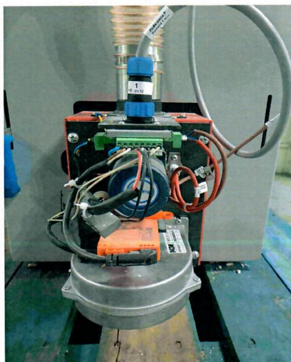
Rysunek 11 Moduł palnika z motoreduktorem i wentylatorem nadmuchowym
