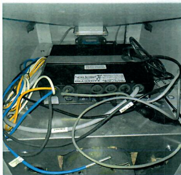
Rysunek 9 Moduł sterownika PELLPAL PLUS firmy ProND
